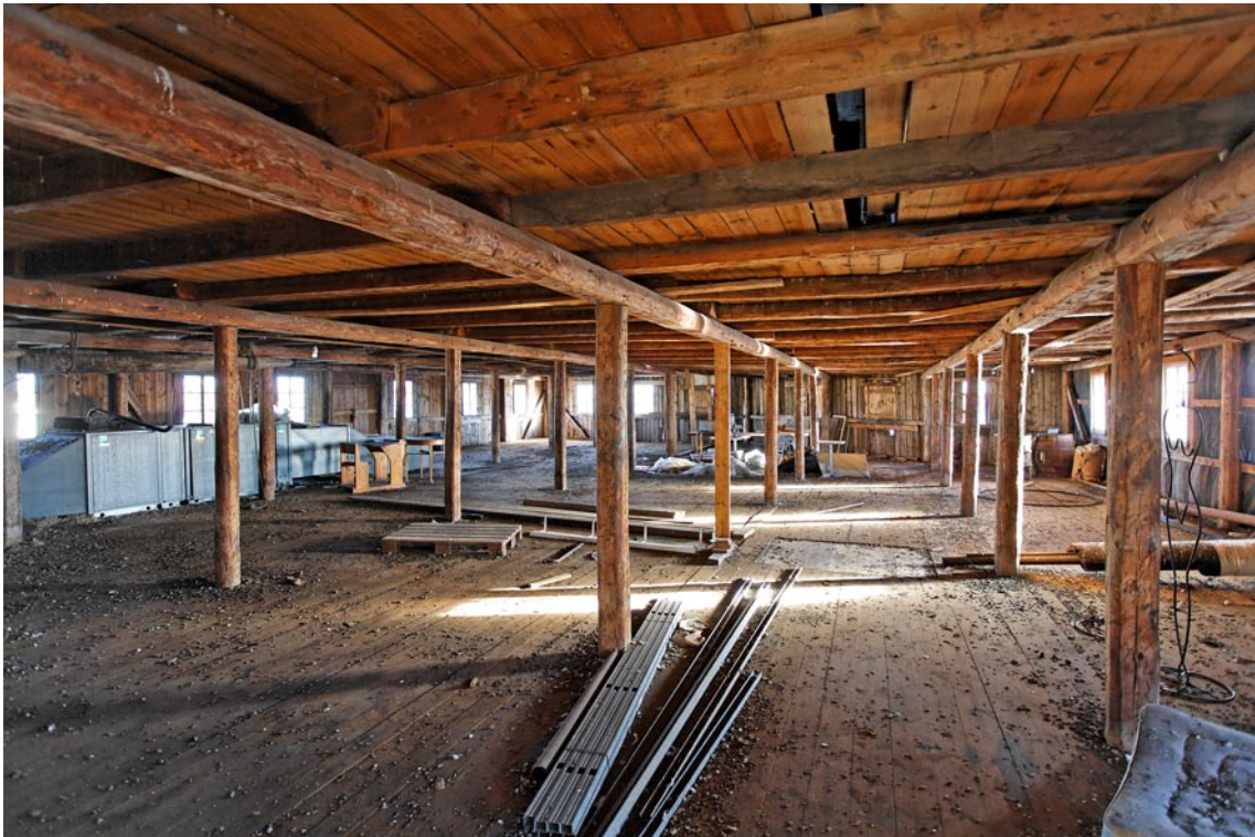
Vinden utgörs av en stor öppen yta med bärlinor och och stöttor jämt fördelade över rummet. Foto: Lars Mongs.
