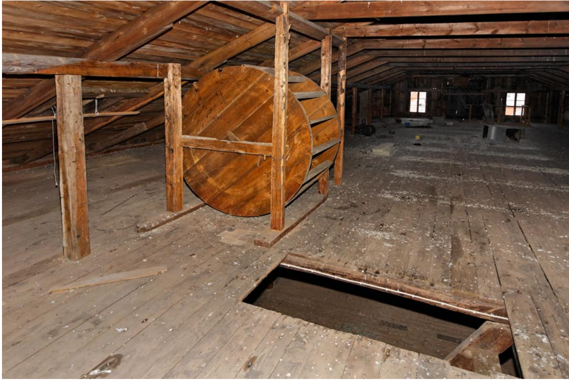
Traditionell handvinsch för transport av varor till och från magasinets olika våningar. Foto: Lars Mongs.
