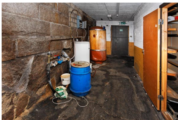
I bottenvåningen utmed den ursprungliga gaveln åt väster syns de gamla grundmurarna. Foto: Lars Mongs.
