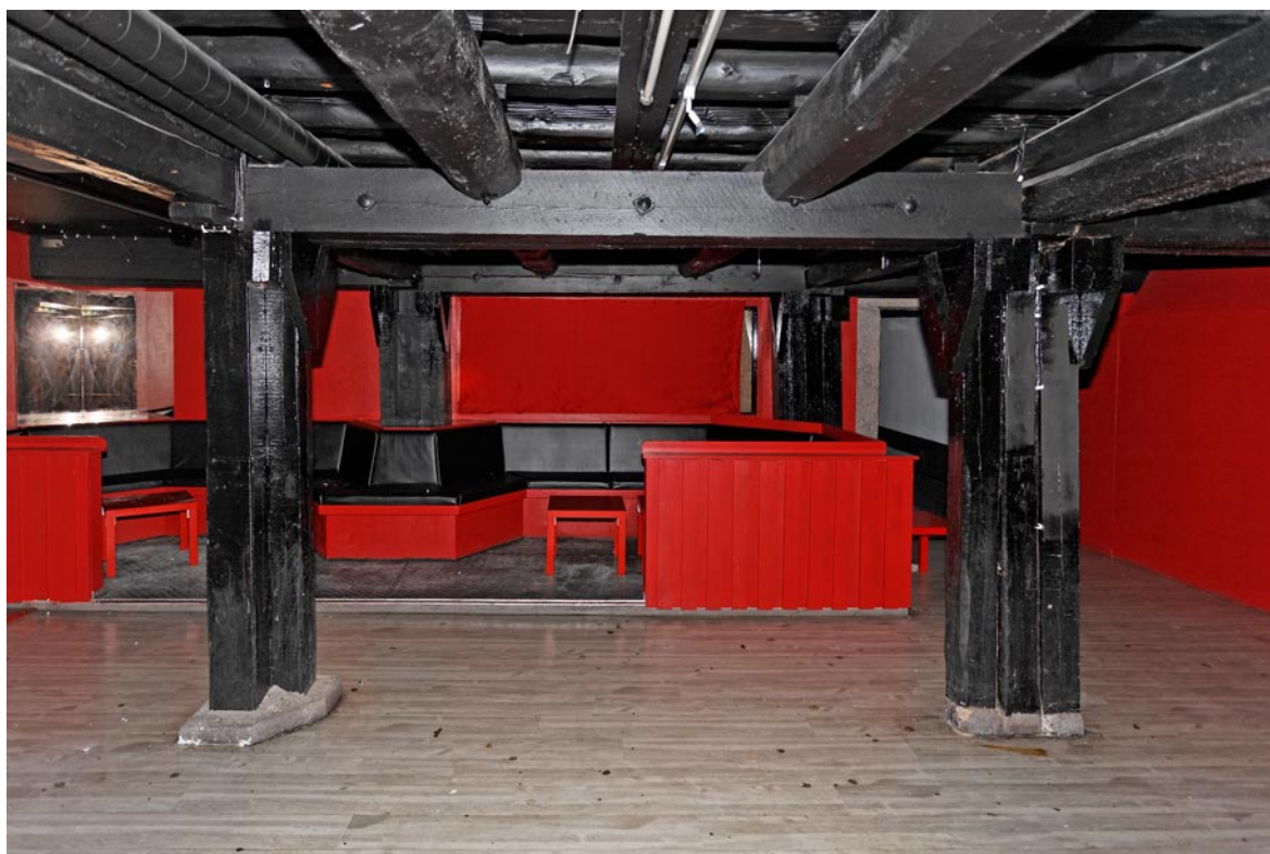
Bottenvåningen med dess kraftiga stöttor från golv till tak samt det likaledes kraftiga bjälklaget i taket. Foto: Lars Mongs.
