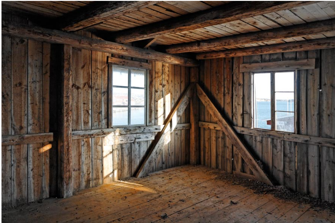
Konstruktionen av magasinet är traditionell med stöttor, hammarband och bjälklag. För att skapa en förstyrkning i hörnen har man här lagt in snedsträvor. Foto: Lars Mongs.
